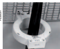
Assemblaggio in piastra di montaggio.
